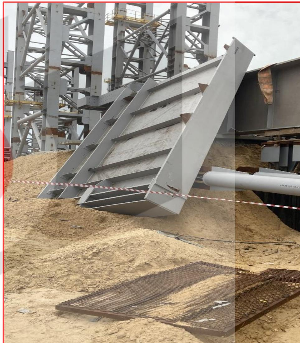
В январе 2023 года при выполнении работ по демонтажу бетонных плит противовеса башенного самомонтируемого крана произошло его падение на объект строительства. ППР, ТК на монтаж/демонтаж башенного самомонтируемого крана, предусмотренная п. 31 ФНП по ПС, разработаны не были.
